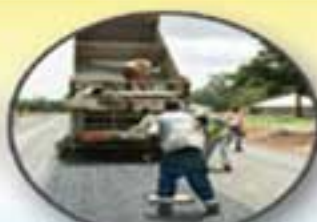
Aménagement de chaussées
